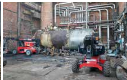
Ontmanteling van de grote tanks van de voormalige ketelruimte, Boilerroom genaamd
