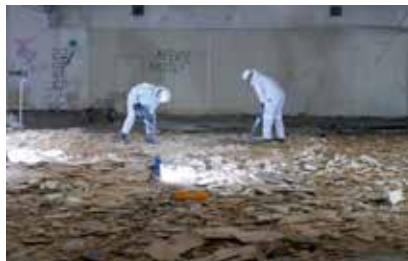
Asbestverwijdering uit oude vloerbedekking
