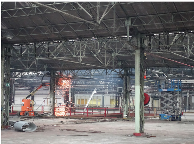
Démantelement et démolition
