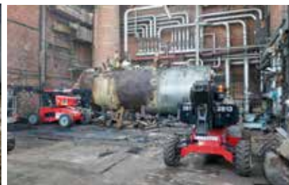
Démantèlement des grandes citernes de l'ancienne chaufferie appelée Boilerroom
