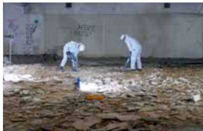
Désamiantage des anciens revêtements de sol
