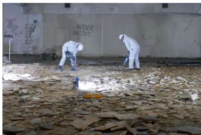
Désamiantage des anciens revêtements de sol
