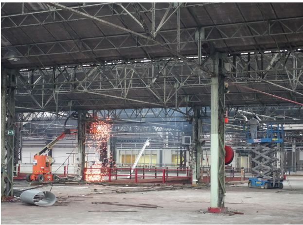
Démantelement et démolition
