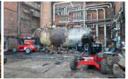
Ontmanteling van de grote tanks van de voormalige ketelruimte, Boilerroom genaamd
