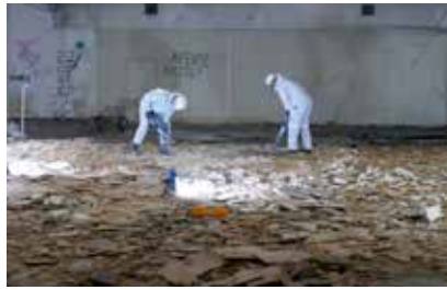
Asbestverwijdering uit oude vloerbedekking
